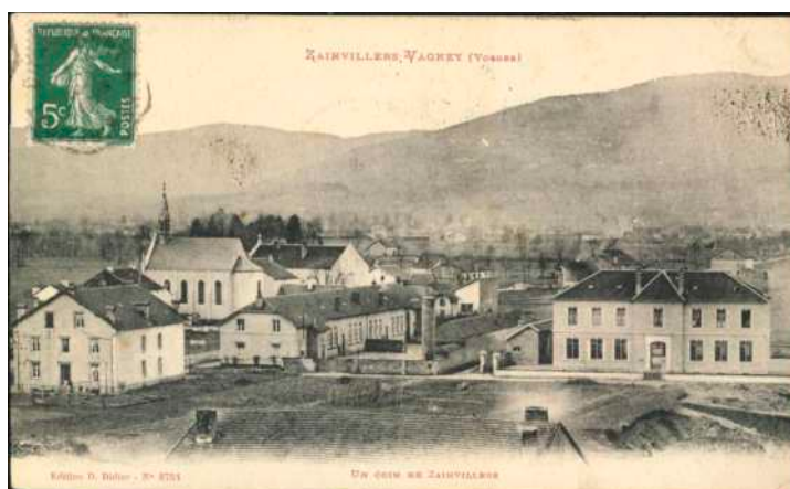
L'école de Zainvillers (Arch. dép. Vosges, 4 Fi 486/9, 4063)
