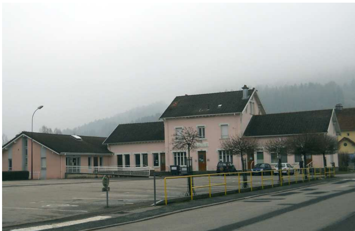
Le bâtiment des anciens bains-douches à Fraize, aujourd'hui occupé par le Centre d'animation communal. Cliché Sylvia Ancel.
