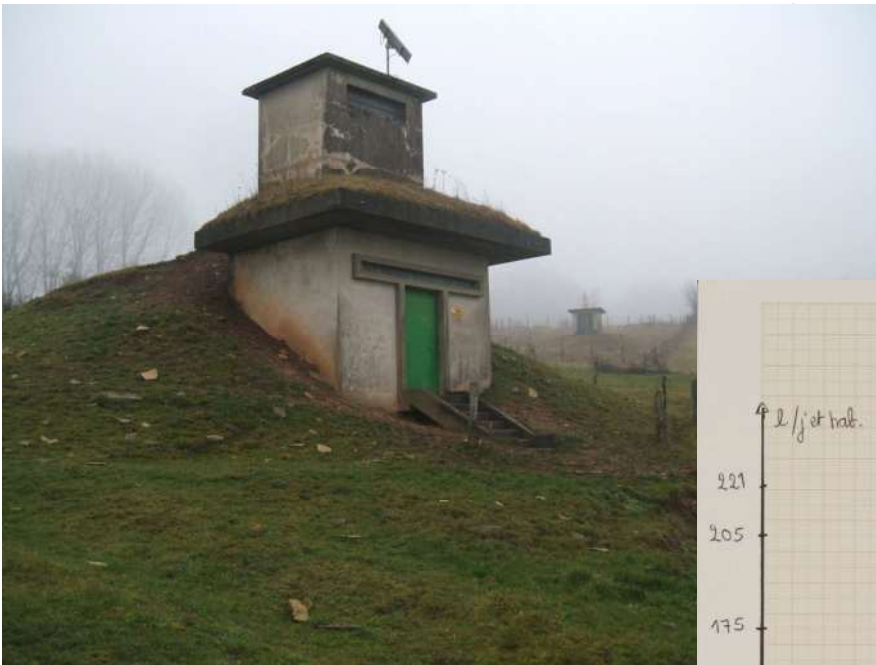
Réservoir d'eau de Gircourt-lès-Viéville. Cliché Judith Rodriguez.
