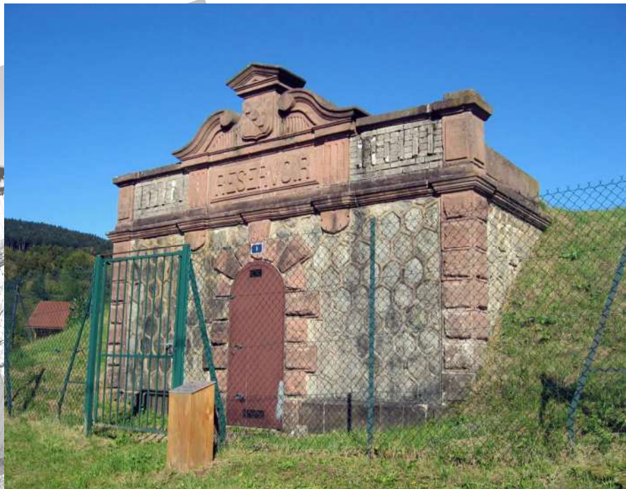
Le réservoir de Scarupt à Fraize. Cliché Didier Perrin.
