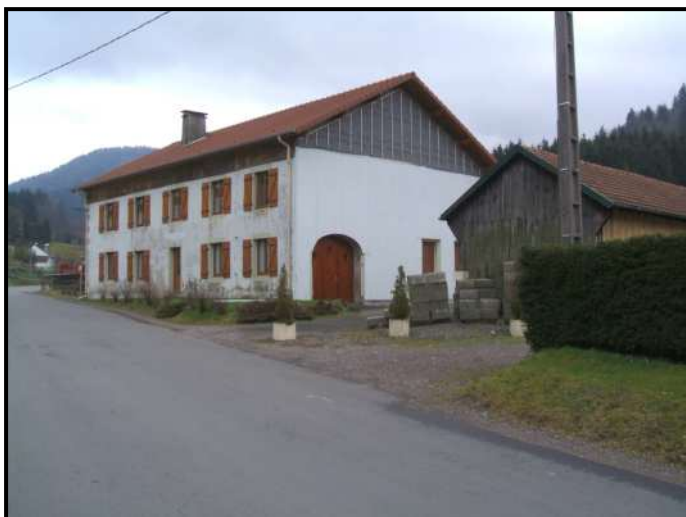
Le bâtiment de l'ancienne école de Taye 2007
