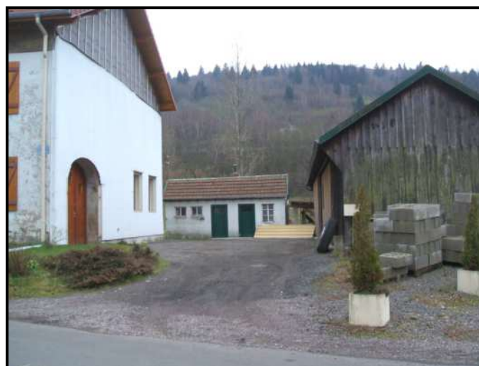
Les toilettes et le préau de l'école
